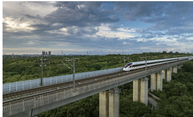
图二 厦门轨发基础设施债权投资计划投资项目
